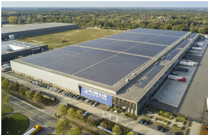
Zonnepark op platte daken, onder andere van bedrijventerreinen en winkelcentra (referentie distributiecentrum bij Eindhoven).
