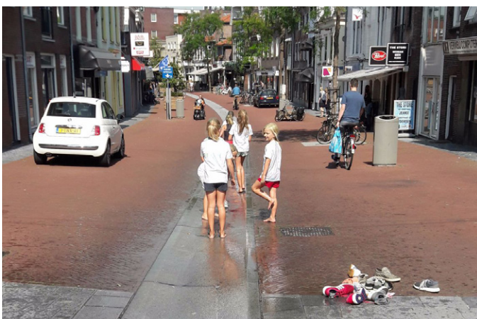
Bovengrondse waterafvoer. Referentie Woerden.
